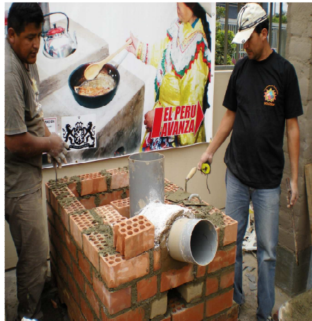
Figura 2: Proceso de construcción (SOLCODE)
