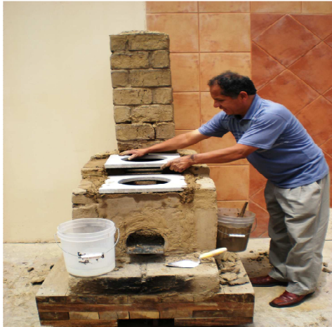
Figura 1: Proceso constructivo (ITYF)
